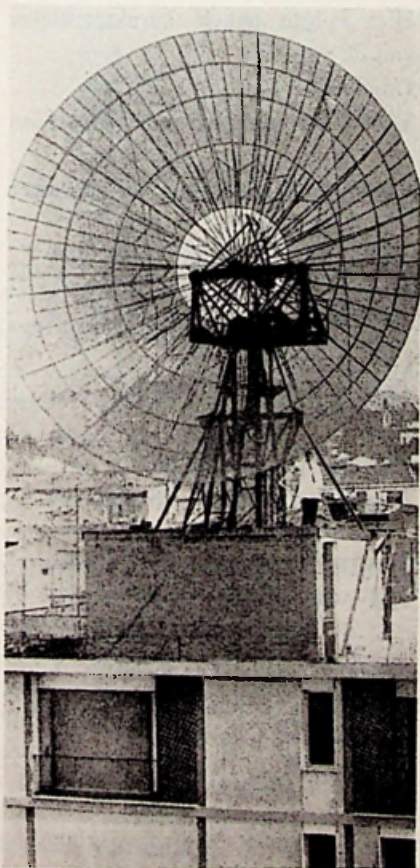
De parabool in verticale stand; onder de parabool bevindt zich het kleine „dak-labo”
